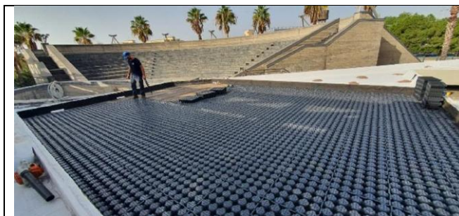
Instalação de unidades de drenagem
