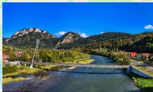
Ponte Internacional Polónia - Eslováquia
