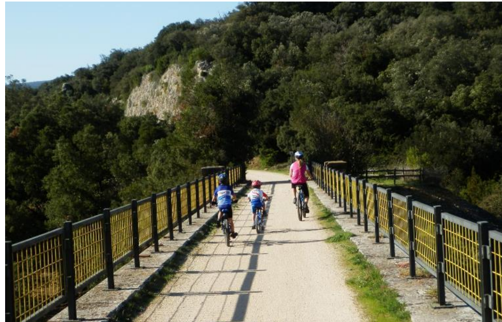
Vía Verde del Ferrocarril Vasco Navarro
