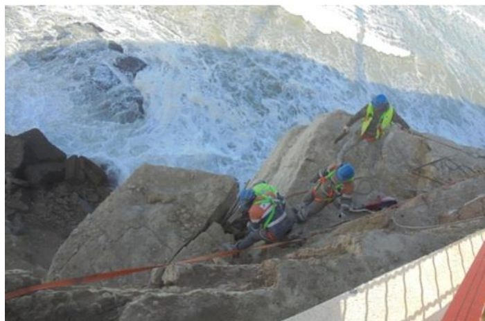
(1) Vista geral da área de intervenção - meios elevatórios; (2) Limpeza da vegetação e materiais soltos (3) e (5) Reperfilamento de bancadas rochosas em consola; (4) Demolição controlada de consola;
