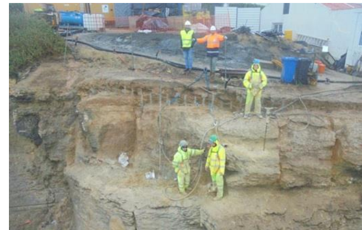
(1) Vista geral da área de intervenção - meios elevatórios; (2) Limpeza da vegetação e materiais soltos (3) e (5) Reperfilamento de bancadas rochosas em consola; (4) Demolição controlada de consola;
