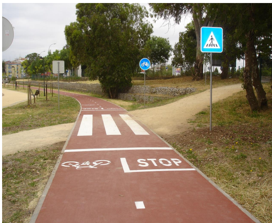
Regularização de pavimentos , ciclovia betuminosa pintada e eliminação de barreiras arquitetónicas.
