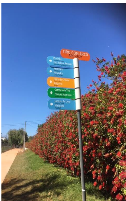
Colocação de postes metálicos com sinalética impressa em vinil autocolante
