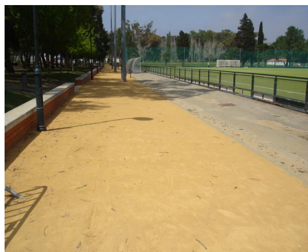
Pisos em saibro estabilizado
