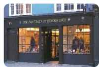
Pequeno Edifício Comércio e Serviços (PES)
